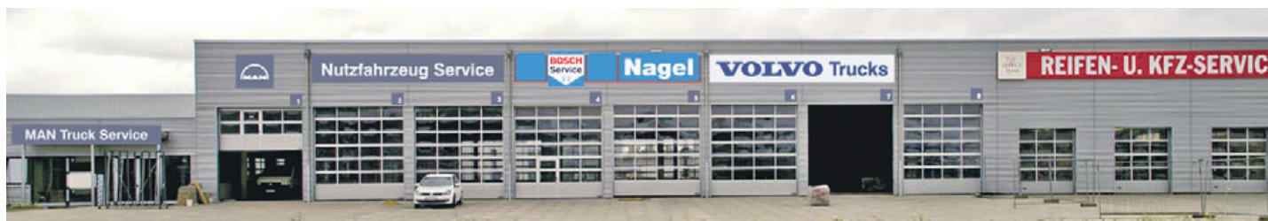
Voraussichtlich Anfang 2012 wird die Hans Nagel GmbH in den Hallenkomplex einziehen
